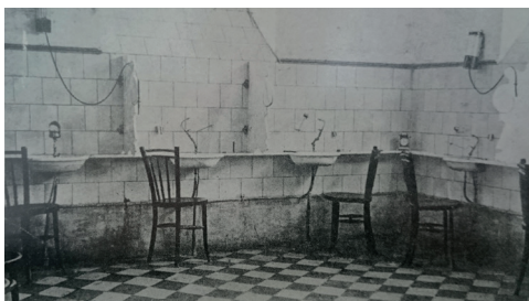
Sala de pulverización.
