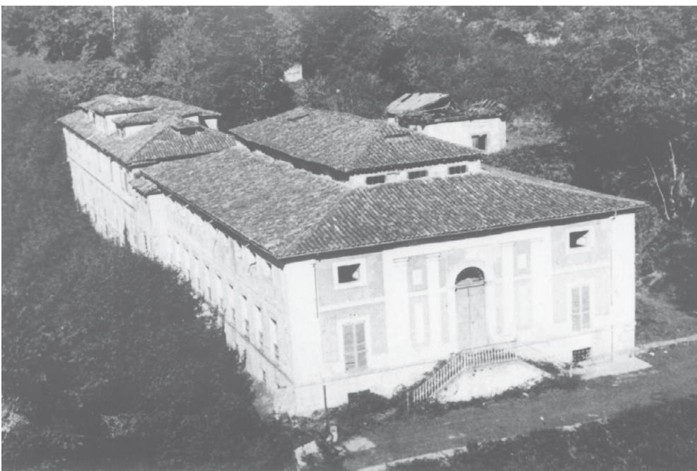
Dos vistas generales del establecimiento en las que se aprecia la ampliación del balneario realizada en 1884.
