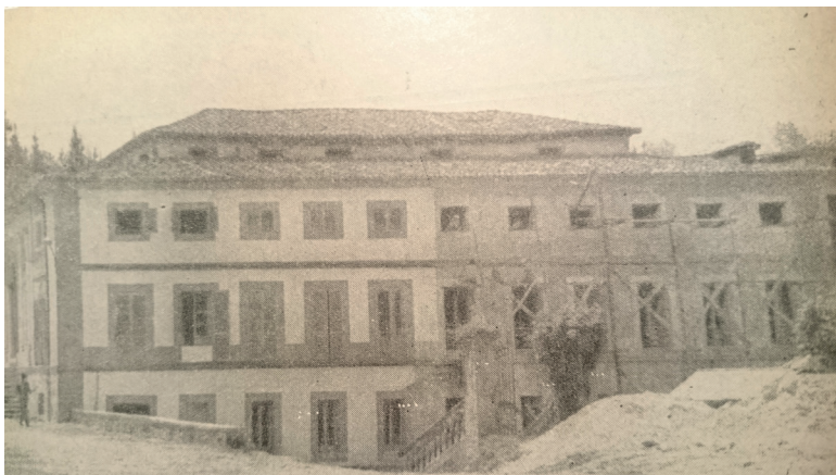
Obras de adecuación del balneario como planta embotelladora, 1968.
